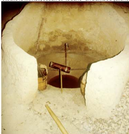
Fours à nitrates, Daxiao Dong, province du Guizhou, comté de Luodian, Chine : citerne dans laquelle était stocké le lixiviat ; seaux et "louche" en bambou (cliché Audra 1986)
