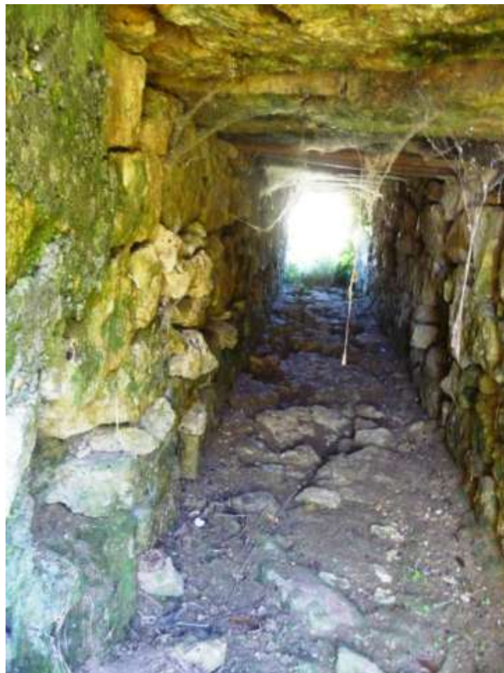
Tunnel aménagé servant de pont et permettant au bief d'aller du ruisseau au moulin
