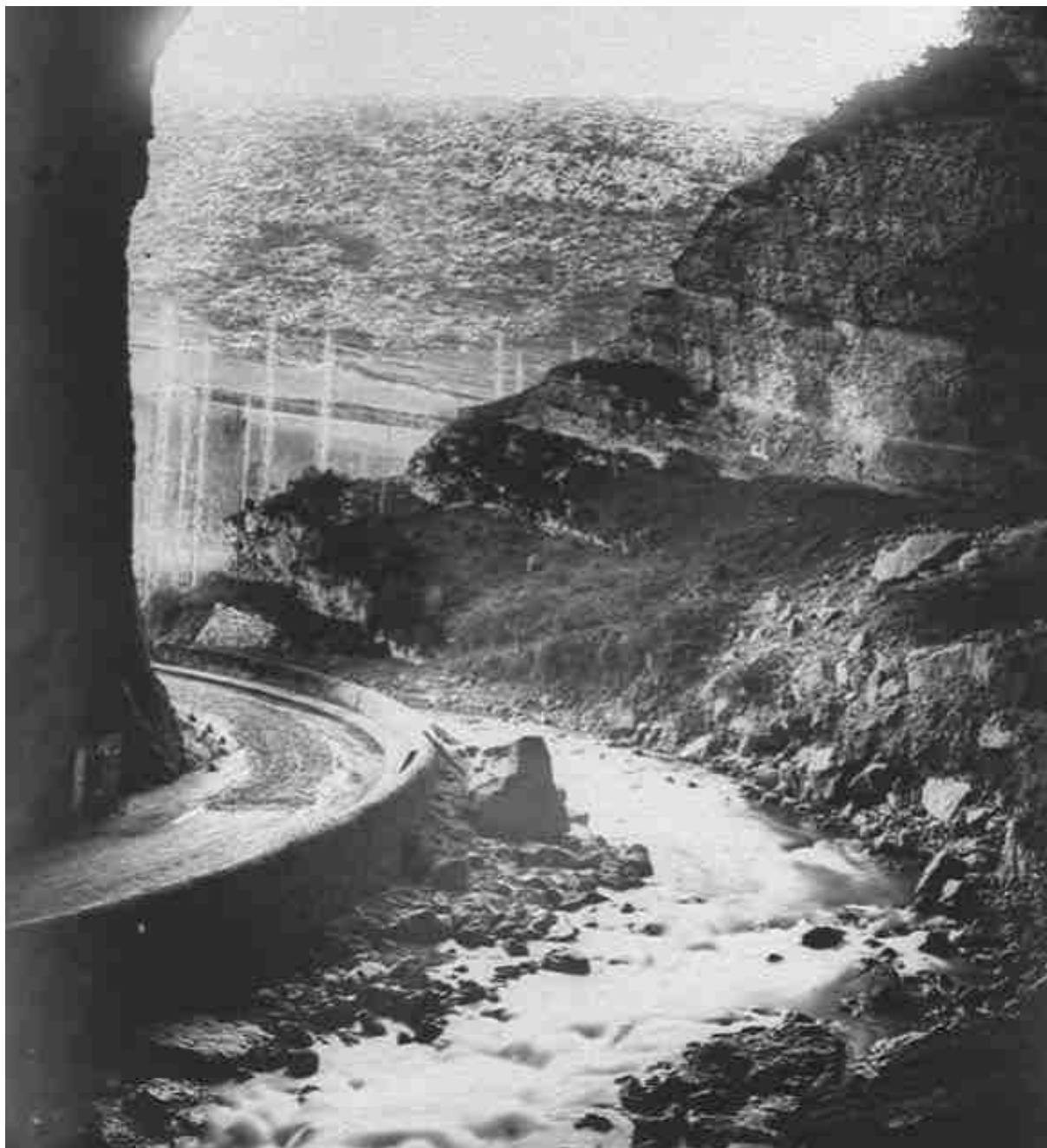
figure 20 : vue du porche sud depuis l'intérieur de la grotte, circa 1867. Photographie de Provost in Faraguet, 1866 : planches photographiques publiées par le Ministère de l'agriculture, du commerce et des travaux publics à l'occasion de l'exposition universelle de Paris en 1867.
