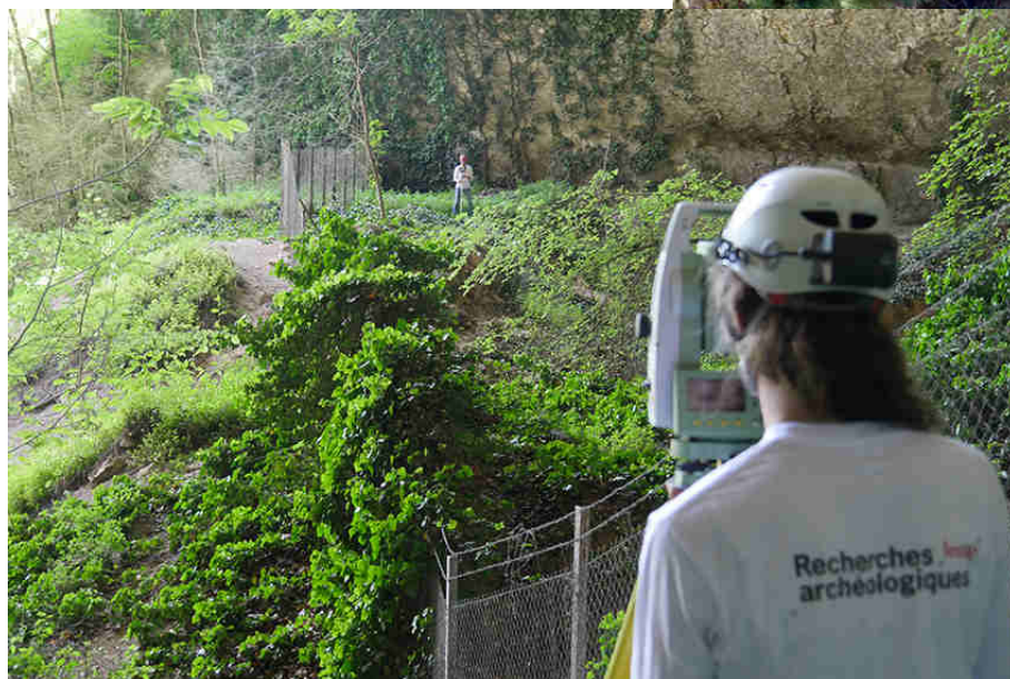
figure 26 : levé des points de calages topographiques du modèle 3D de la Rive Gauche. Cliché © Marc Jarry / Inrap-Traces.
