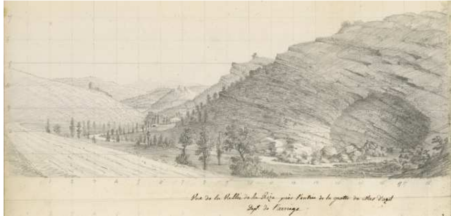
figure 6 : dessin à la mine de plomb de Cervini Melling, "Voyage pittoresque Pyrénées françaises" 1826-1830, vue de la grotte avant la construction de la route. Res B XIX 467(2) © Bibliothèque Municipale de Toulouse, J.-P. Boussière.
