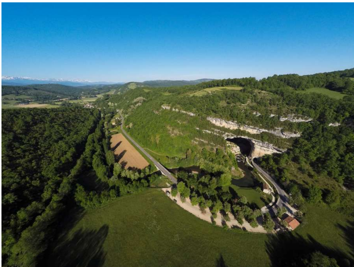
figure 1 : vue aérienne du porche sud de la grotte du Mas d'Azil (cliché © Denis Gliksman/Inrap).
