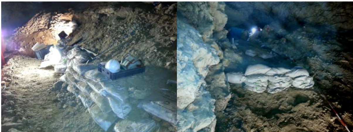
figure 14 : exemples d'utilisation des sacs à gravas pour stocker les déblais hétérogènes dont l'origine n'est pas attestée (cliché © Marc Jarry / Inrap Traces).
